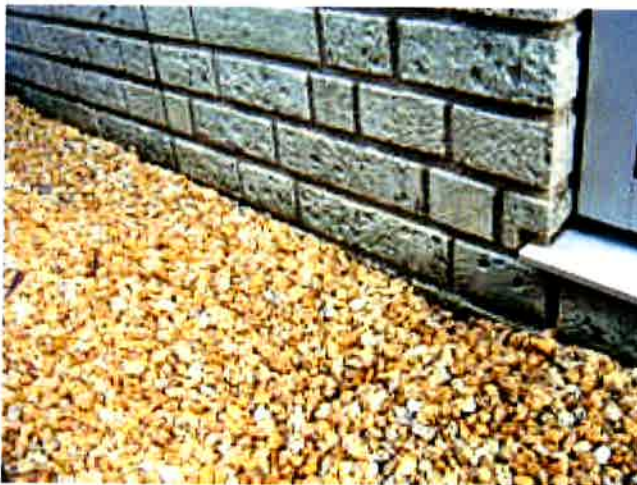
作業後 2) 汚染部位 : 写真 2
