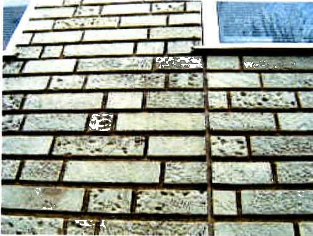
作業後 1) 汚染部位 : 写真 1
